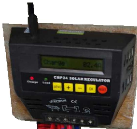
en 2011 nous avons ajouté des panneaux supplémentaires et en 2012 nous avons remplacé notre régulateur par un MPPT de 40A , SOLARMATE CHARGE CONTROLEUR
